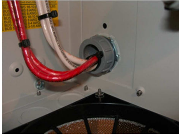
Figure 22 - PV Conduit
